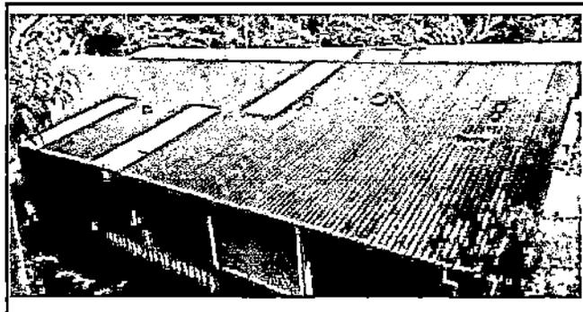
Foto 2: Se cambiará techado porque el que está tiene varias goteras
